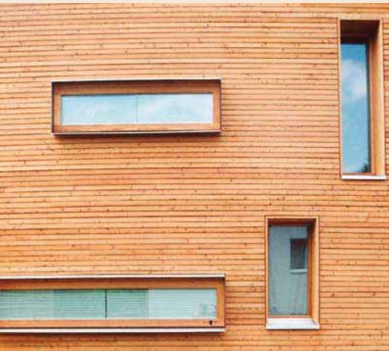
Dem aktuellen Trend einer klaren einfachen Formensprache entspricht die hölzerne Fassadengestaltung mit einer hinterlüfteten Rhomboidschalung.
