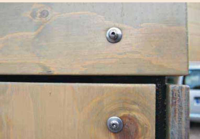
Der Einsatz von dauerhaft nichtrostenden Edelstahlstahlschrauben verringert den Wartungsaufwand der Fassade.
