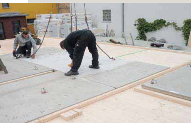
Verlegung von Betonfertigteilelementen mit integrierten Würth FT-Verbindern.
